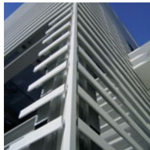
Bâtiment social Microturbo (31 TOULOUSE) SELARL d'Architecture Jean-Pierre Larrouy | SOPOCOME TROPIQUE
