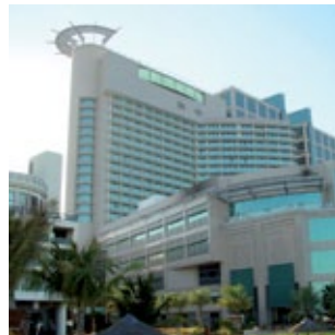
Abou Dhabi Trade Center (ÉMIRATS ARABES UNIS) Hellmuth, Obata & Kassabaum, Inc | TECHNAL LONGITUDE
