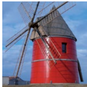
Moulin de Nailloux (31 NAILLOUX) Axel Letellier | CGEM LAME SZ20
