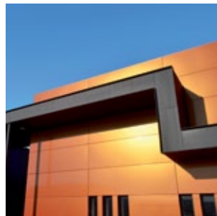
Usine Serco France (64 PAU) Architectes Camborde Lamaison | CANCE NAY LONGITUDE
