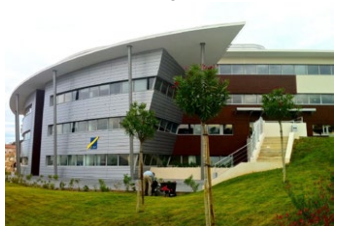
Villaflor (13 MARSEILLE) Deleplanque Architecte | S.P.C.M
